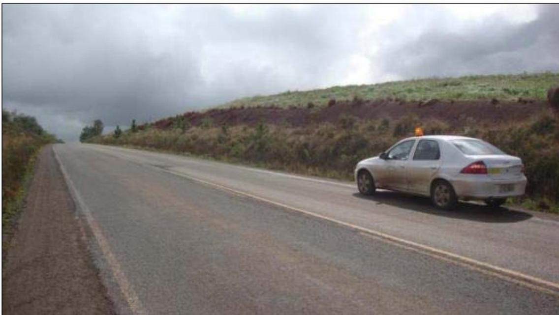
**Foto 01:** Talude de corte em solo sem a presença de vegetação em sua parte superior. A ausência do recobrimento gera um progressivo processo de erosão laminar oriundo do escoamento superficial de água. Cabe ressaltar que as atividades relacionadas às lavouras adjacentes também interferem no desenvolvimento da vegetação e na erosão das faces dos taludes.
