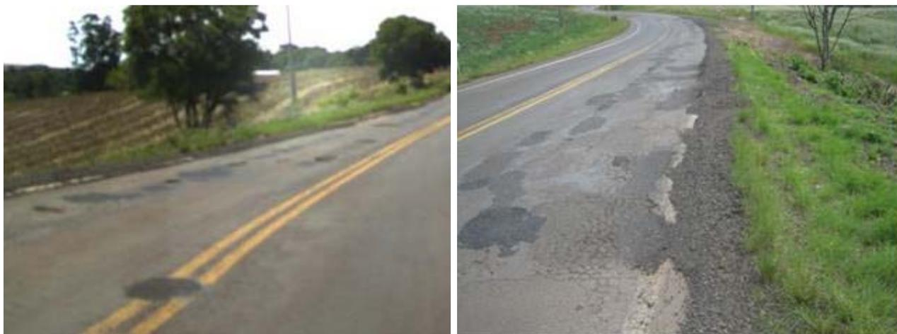
**Figura 18 - Reconstrução no km 21+100: 120 metros em na faixa do lado esquerdo e acostamento**
