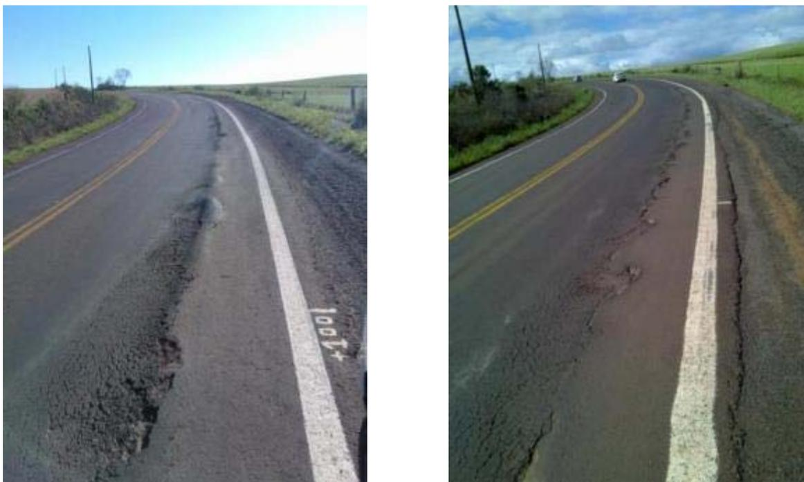
**Figura 19 - Reconstrução no km 23+100: 150 metros na faixa do lado direito e acostamento**
