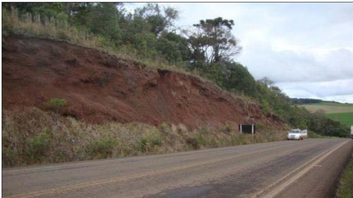
**Foto 10:** Erosão acentuada em talude de solo e saprólito.
