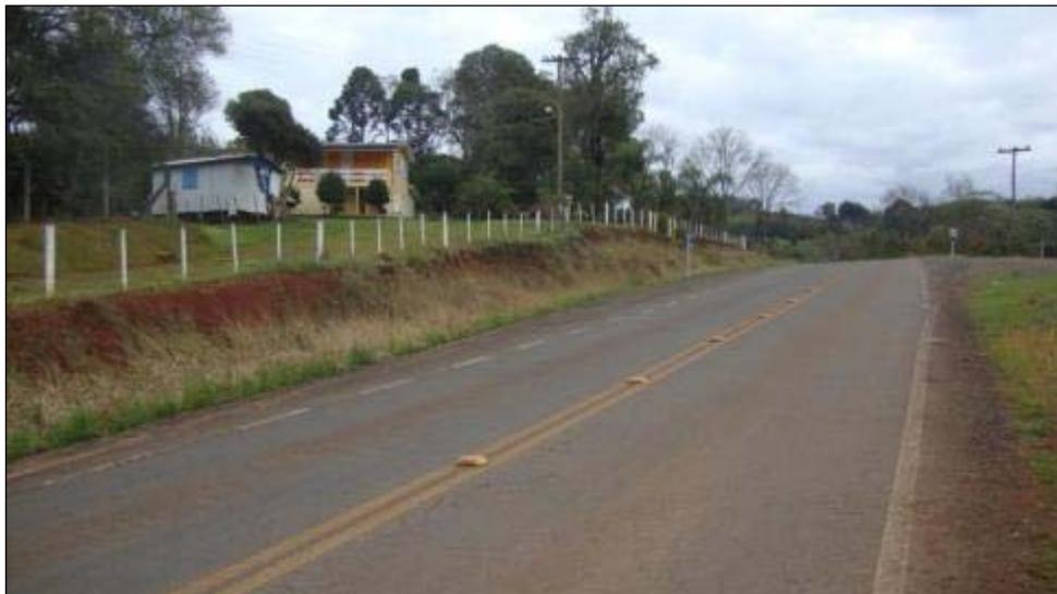
**Foto 09:** Exemplo de talude de pequena altura, vegetado na base e que não apresenta grande contribuição de sedimentos para os dispositivos de drenagem, visto que os mesmos ficam retidos na vegetação. No entanto, para que se possa proporcionar maior estabilidade frente a processos erosivos oriundos do escoamento superficial de água, é interessante que a parte superior do talude seja recoberta por gramíneas.
