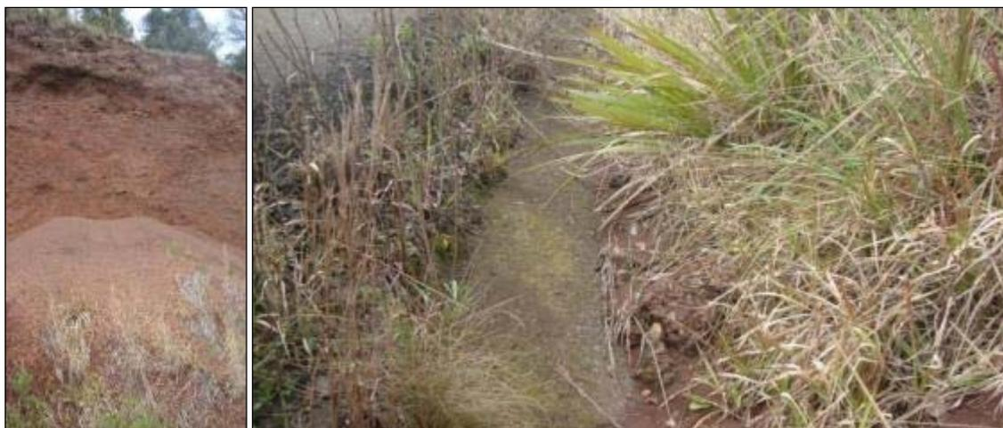
**Foto 12:** A erosão dos horizontes B e C ocasiona a deposição de sedimentos na base do talude de corte e no assoreamento parcial do sistema de drenagem superficial.
