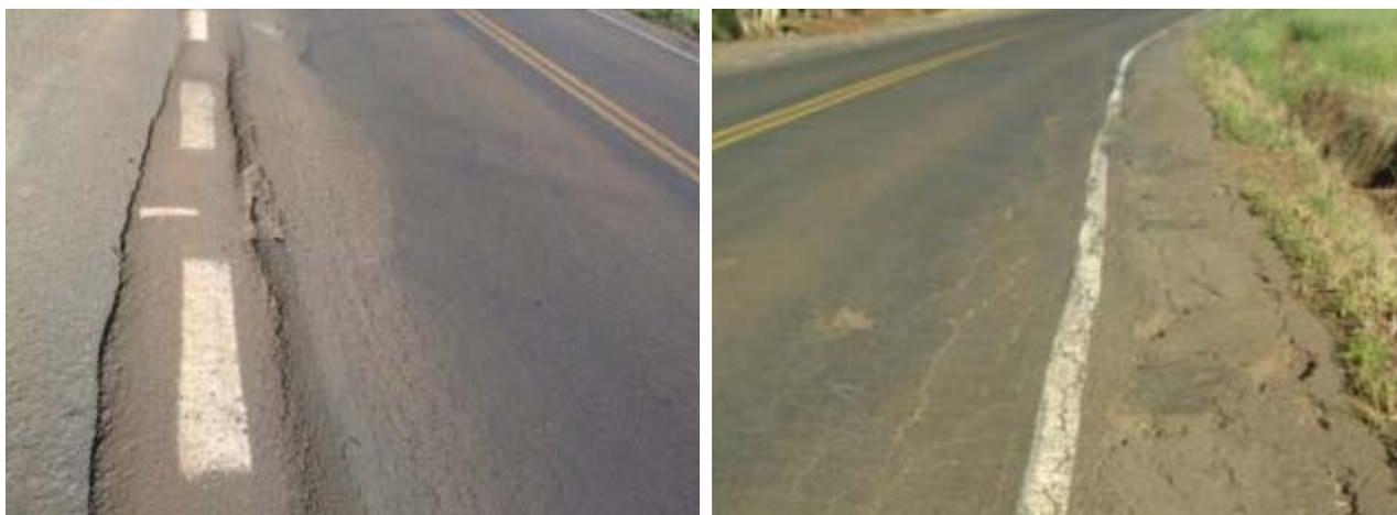
**Figura 17 - Reconstrução no km 19+100: 100 metros nas 2 faixas e acostamentos**
