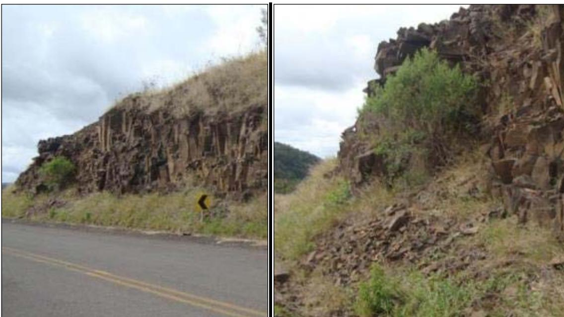
**Foto 34:** As partes superiores e inferiores dos derrames de rochas vulcânicas básicas geralmente apresentam grande quantidades de fraturas verticais e horizontais decorrentes do rápido resfriamento dos magmas. Essas fraturas geram pequenos blocos de rocha que facilmente se desprendem da face do talude. O processo de queda e acúmulo na base dos taludes assoreia o sistema de drenagem superficial.
