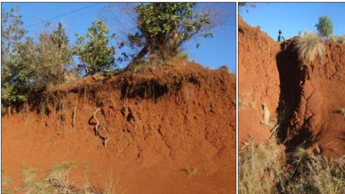
**Foto 24** (bordo direito da rodovia): Detalhe do descalçamento da base de exemplares arbóreos (à esquerda), expondo raízes e possibilitando a queda dos mesmos. À direita observa-se a presença de feição erosiva linear (ravina) onde é concentrado o fluxo do escoamento superficial e que progressivamente desestrutura o talude.
