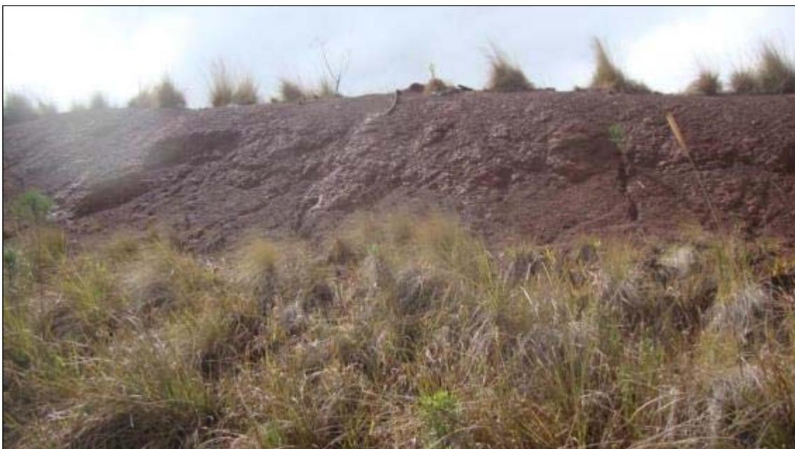
**Foto 02:** Vista em detalhe da parte superior do talude sem cobertura vegetal. Além da erosão laminar, difusa, ocorre em alguns pontos a concentração do fluxo do escoamento superficial, gerando pontos de erosão linear (sulcos) que podem progredir para ravinas. Em geral, a erosão linear representa maior potencial para causar danos estruturais aos taludes, quando comparada à erosão laminar.
