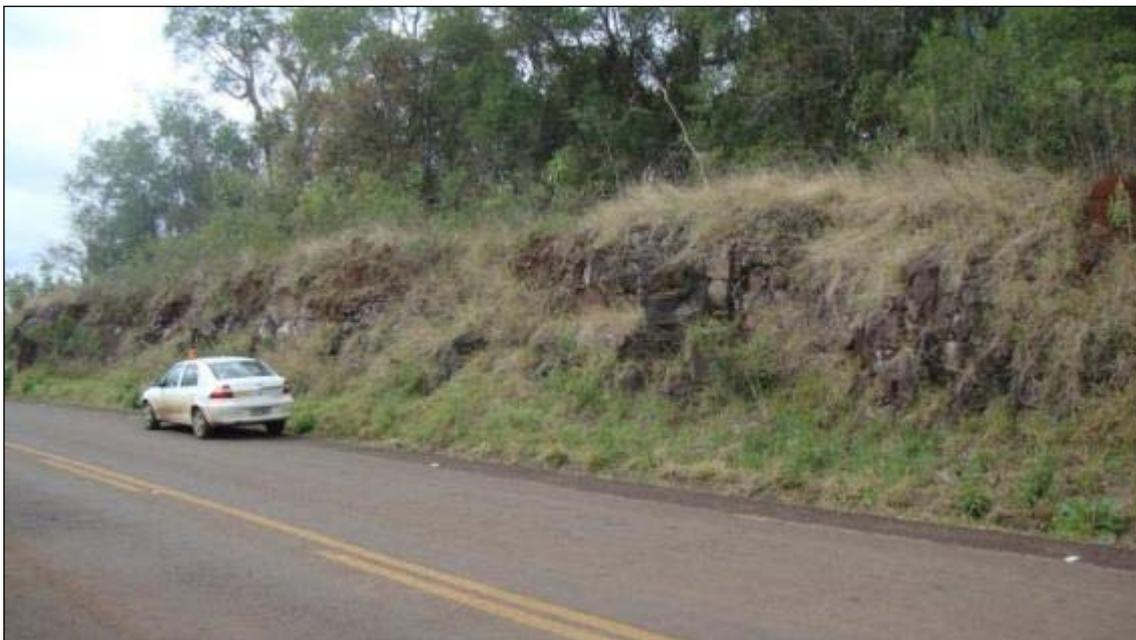
**Foto 30** (bordo direito da rodovia): Talude rochoso onde, localmente, se observa a possibilidade de queda de pequenos blocos.
