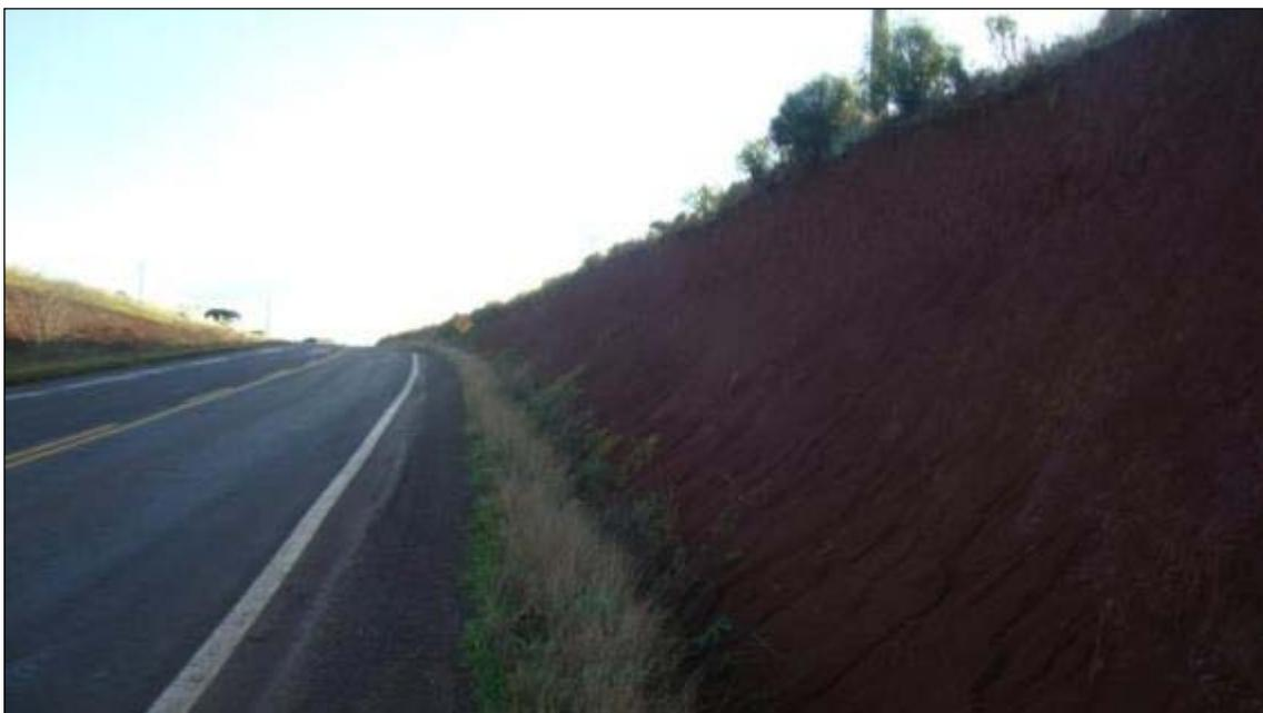
**Foto 28** (bordo esquerdo da rodovia): A falta de cobertura por gramíneas facilita o desenvolvimento do processo de erosão laminar nos taludes de corte. Na foto é possível observar um espesso depósito de sedimentos, erodidos das partes superiores, concentrado na base do talude. Esse processo progressivamente colmata o sistema de drenagem superficial. No presente caso, além das atividades desenvolvidas nas lavouras adjacentes, a posição solar influi na taxa de crescimento de vegetação.
