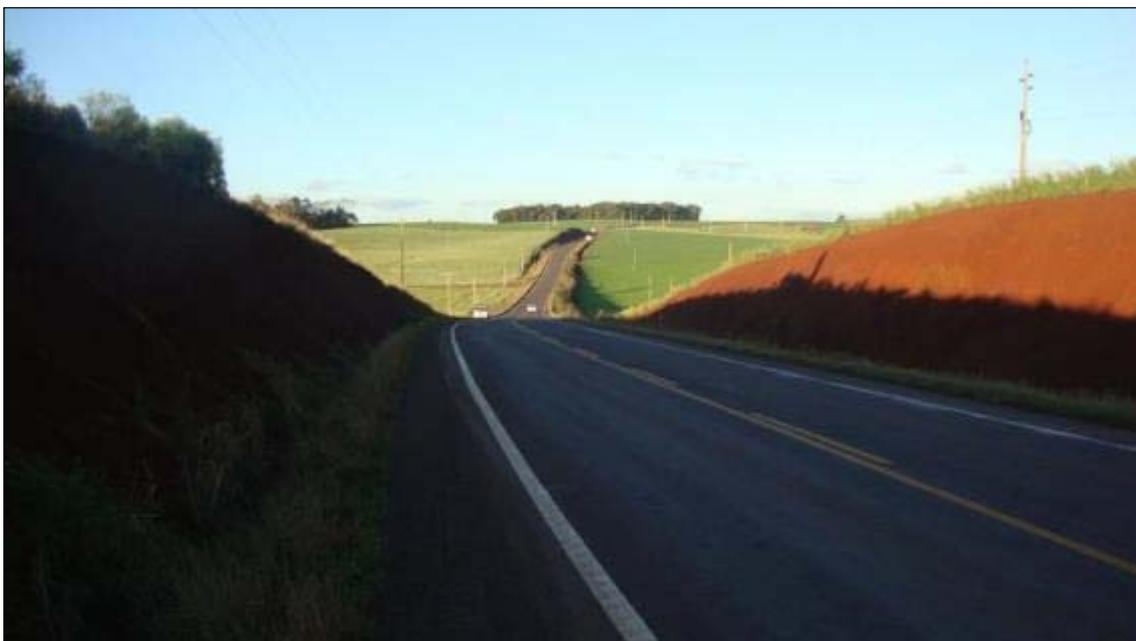
**Foto 26:** Taludes sem cobertura vegetal onde se desenvolve, principalmente a erosão laminar.
