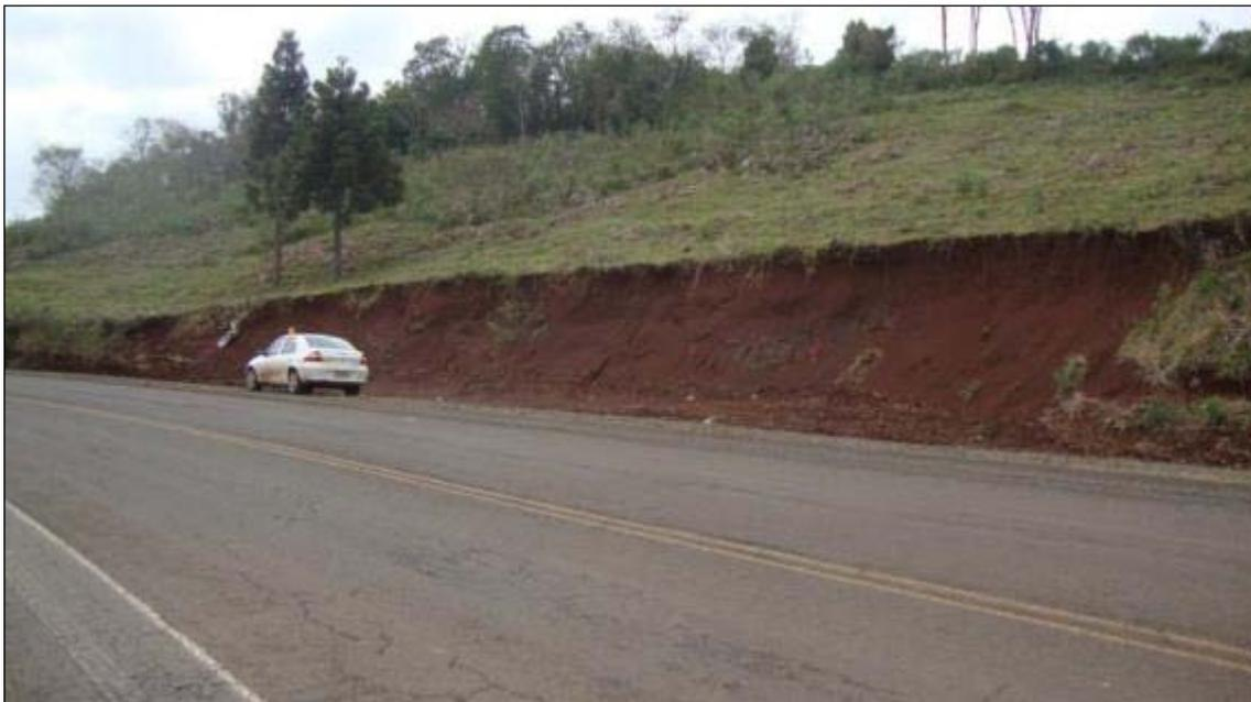
**Foto 03:** Vista ampliada do talude de corte sem cobertura vegetal. A descompressão de sua base pode originar o surgimento de processos de rastejo à montante. A falta de proteção da face do talude por cobertura vegetal potencializa os processos de erosão laminar e linear.
