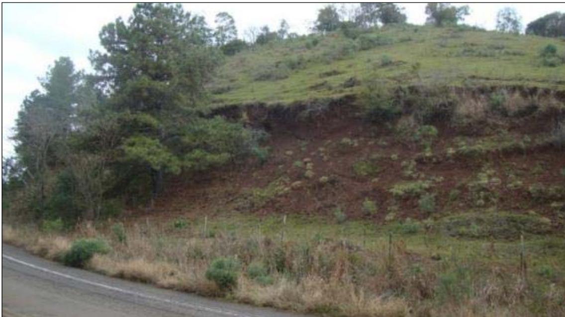
**Foto 13:** A decompressão da base do talude, associado à uma topografia de moderadas a altas declividades em terrenos compostos por considerável quantidade de sedimentos argilosos, em regiões de climas com amplitude térmica elevada e períodos que alternam dias secos e úmidos; são fatores que colaboram para o desenvolvimento de processos de rastejo, como é o caso do ponto apresentado. As trincas nos terrenos de montante evidenciam o processo.
