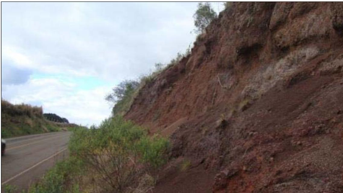
**Foto 11:** Devido às camadas erodidas serem predominantemente do saprólito e do horizonte C, a granulometria do depósito sedimentar acumulado na base do talude é mais grosseira que em outros taludes onde predomina a erosão no horizonte B. A erosão nesse tipo de talude é acelerada e irregular.
