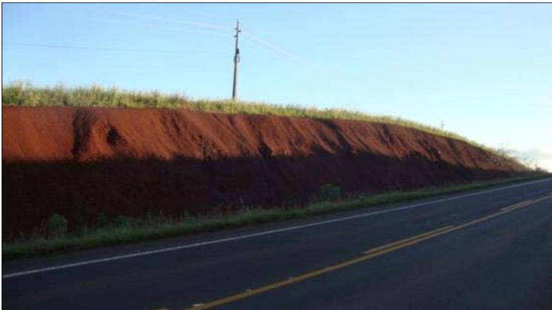
**Foto 27** (bordo direito da rodovia): Grande presença de sulco se desenvolvendo para ravinas e desestruturando o talude de corte.
