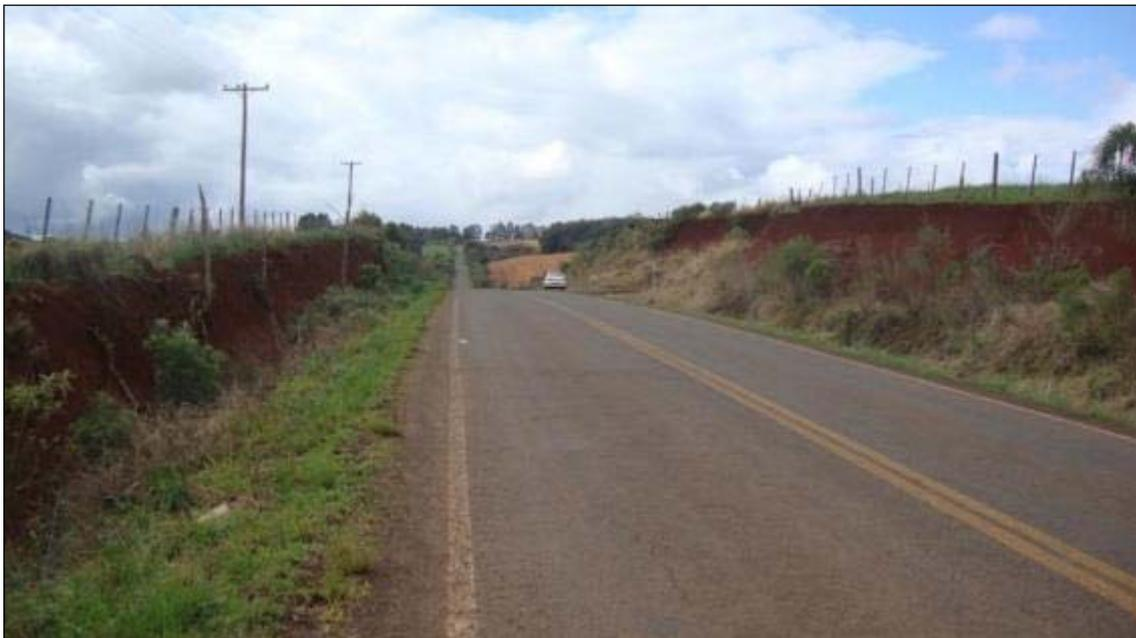
Foto 06: Taludes de corte, em ambos os lados da rodovia, com parte de suas faces expostas.
