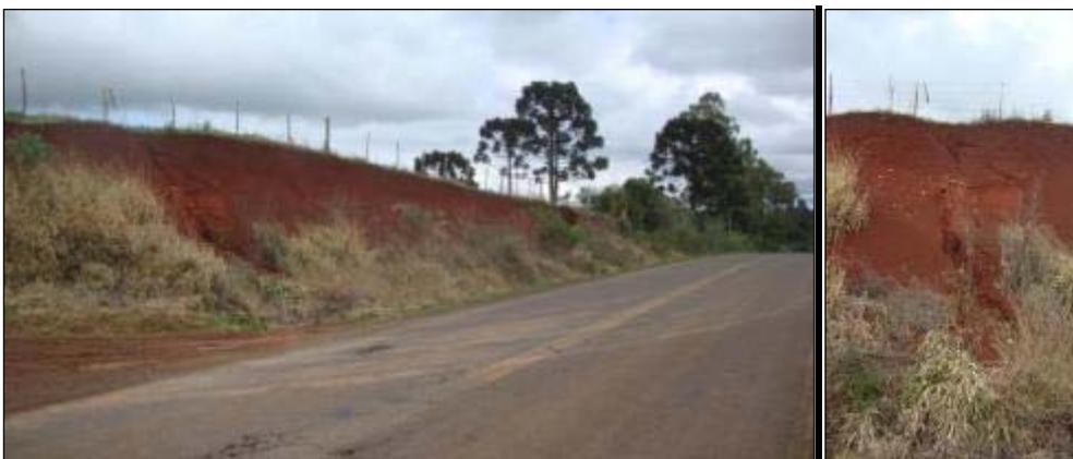
Foto 07 (bordo esquerdo da rodovia): Sulco originado pela ausência de recobrimento vegetal e concentração de fluxo de escoamento superficial. Progressivamente poderá ocorrer o desenvolvimento de sulco para ravina com a consequente desestruturação do talude e perda acelerada das áreas de lavoura.
