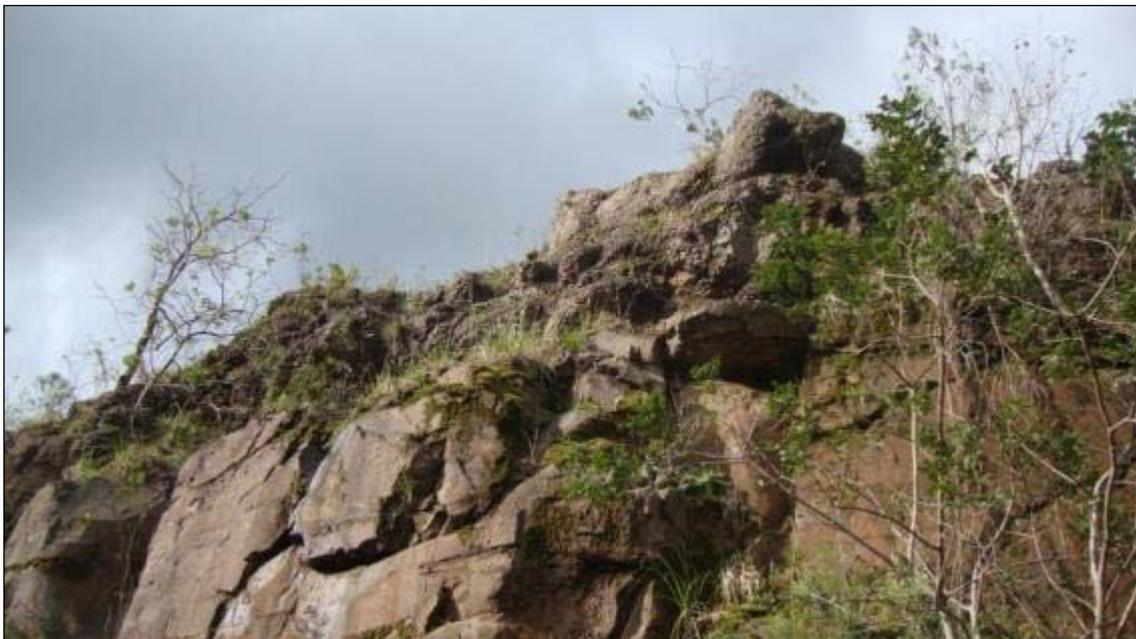
**Foto 17** (bordo esquerdo da rodovia): Exemplo de bloco parcialmente suspenso (topo do talude, centro da foto), que se mostra instável. As raízes das árvores que estão assentadas sobre o talude rochoso contribuem para aumentar o espaçamento das fraturas, bem como proporcionar um efeito de alavanca de acordo com o porte do exemplar arbóreo e da velocidade do vento incidente. No entanto, torna-se difícil precisar quando tal evento poderá ocorrer.
