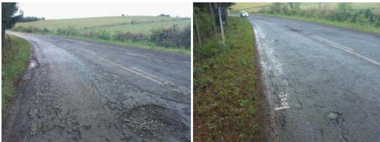
**Figura 09 - Reconstrução: no km 34+200, 160 metros nas 2 faixas e acostamento**
