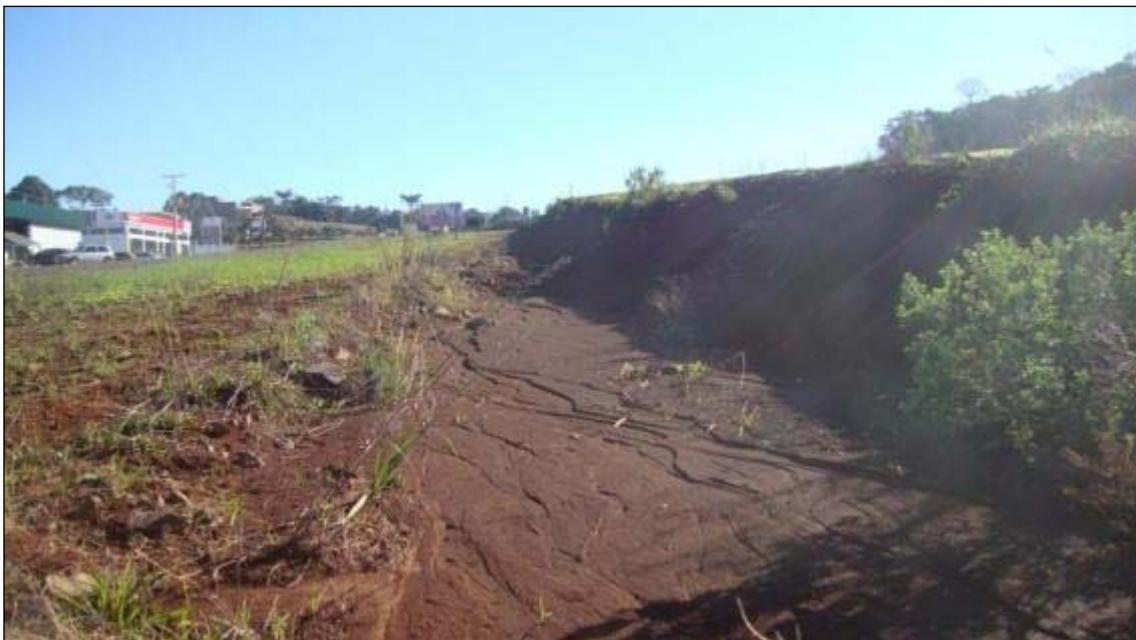
**Foto 20:** Vista de jusante para montante da área de deposição e transporte de sedimentos erodidos dos taludes adjacentes. A quantidade de sedimentos depositados é tão elevada que há formação de um lençol de sedimentos que, morfológicamente, se mostra semelhante aos sistemas fluviais entrelaçados de regime intermitente.
