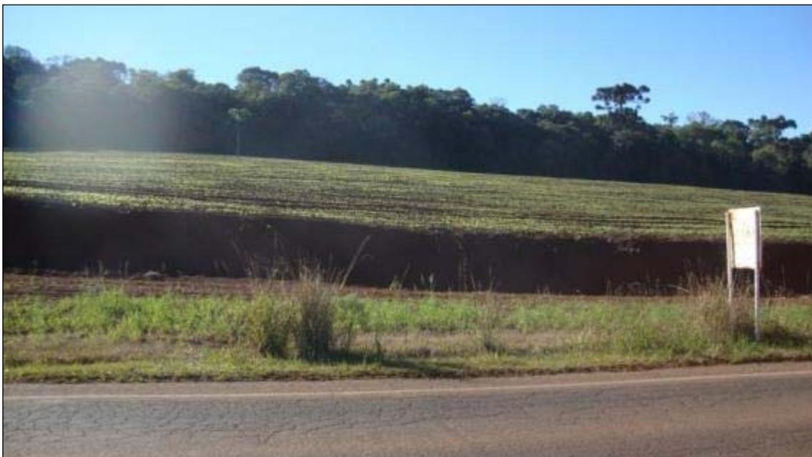
**Foto 19:** A ausência de cobertura vegetal na face e falta de dispositivos de drenagem de base e topo do talude, associadas às práticas utilizadas na lavoura adjacente, contribuem para uma erosão acelerada do solo local.
