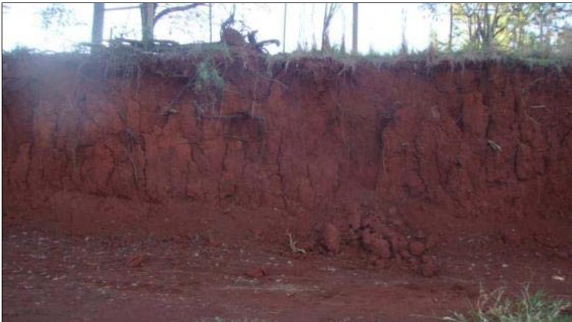
**Foto 25** (bordo esquerdo da rodovia): Após o corte do talude, houve a retirada de umidade do mesmo, ocasionando na formação de blocos de ressecamento que, por perda de coesão, acabam se desprendendo da face do talude.
