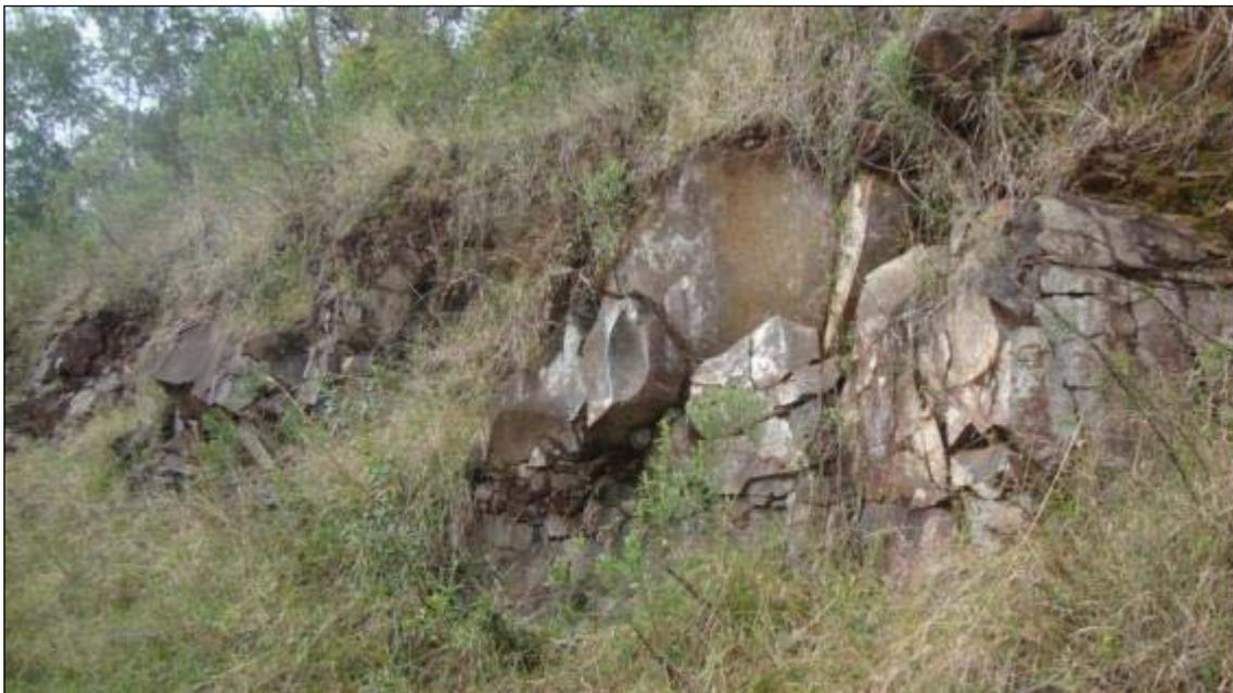
**Foto 31** (bordo direito da rodovia): Bloco suspenso (centro da foto) com grande probabilidade de queda e rolamento para o dispositivo de drenagem superficial.
