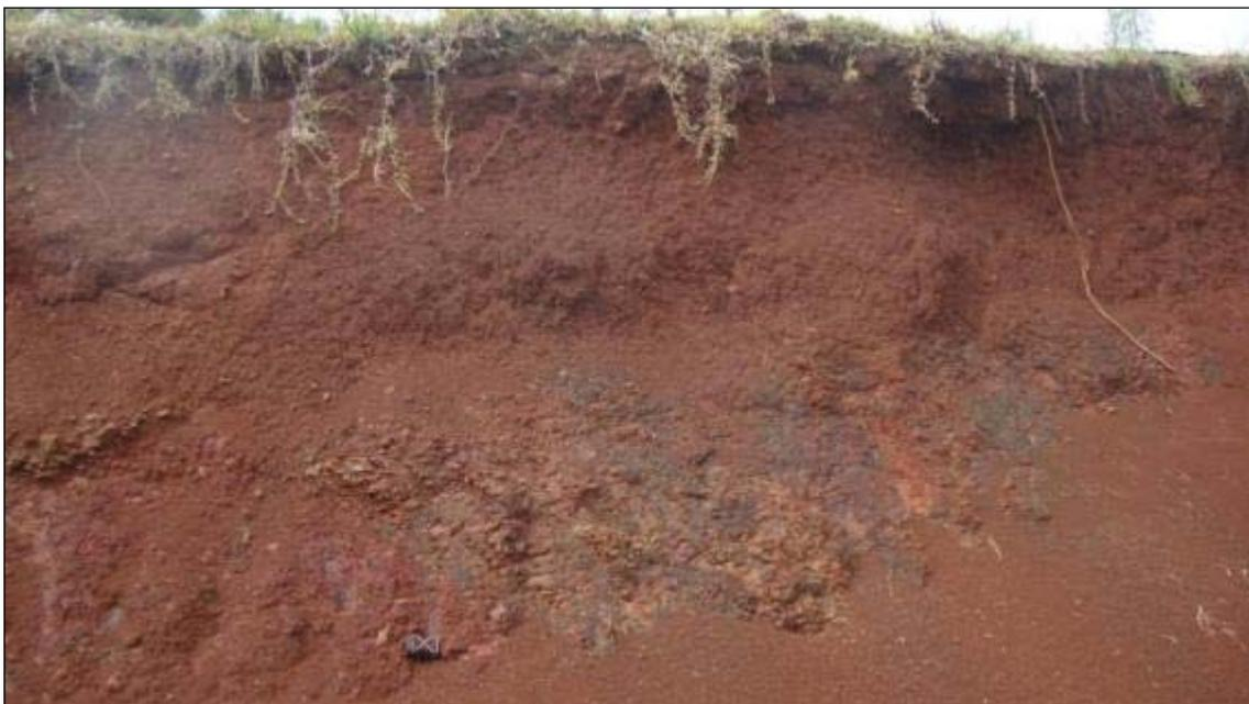
**Foto 04:** Horizontes B e C sendo erodidos e acumulando sedimentos na base do talude de corte. Observar que o horizonte A, por conter maior quantidade de matéria orgânica que, nesse caso, agrega o solo e pelo fato de possuir cobertura vegetal de gramíneas, se mostra mais resistente aos efeitos erosivos do escoamento superficial.
