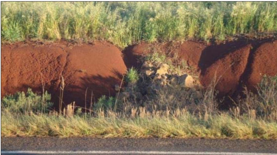
**Foto 29** (bordo direito da rodovia): Ponto com acentuada erosão em sulcos onde foi colocada camada de pedras de mão para conter o desenvolvimento do processo erosivo.
