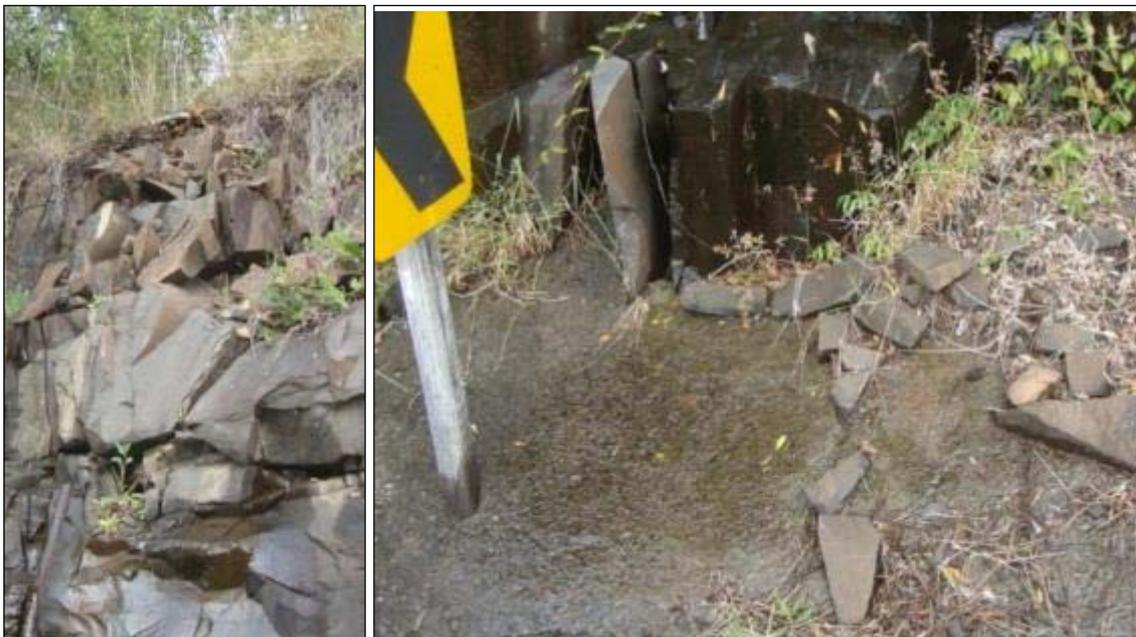
**Foto 33:** Queda de pequenos blocos da face do talude rochoso. Tanto questões naturais como o posicionamento do derrame cortado (se topo, base ou intermediário) pela abertura da estrada, como o plano de fogo utilizado e a própria decompressão do maciço rochosos contribuem para o fraturamento e formação de blocos que, ao cair, interrompem o escoamento do das águas captadas pelo sistema de drenagem.
