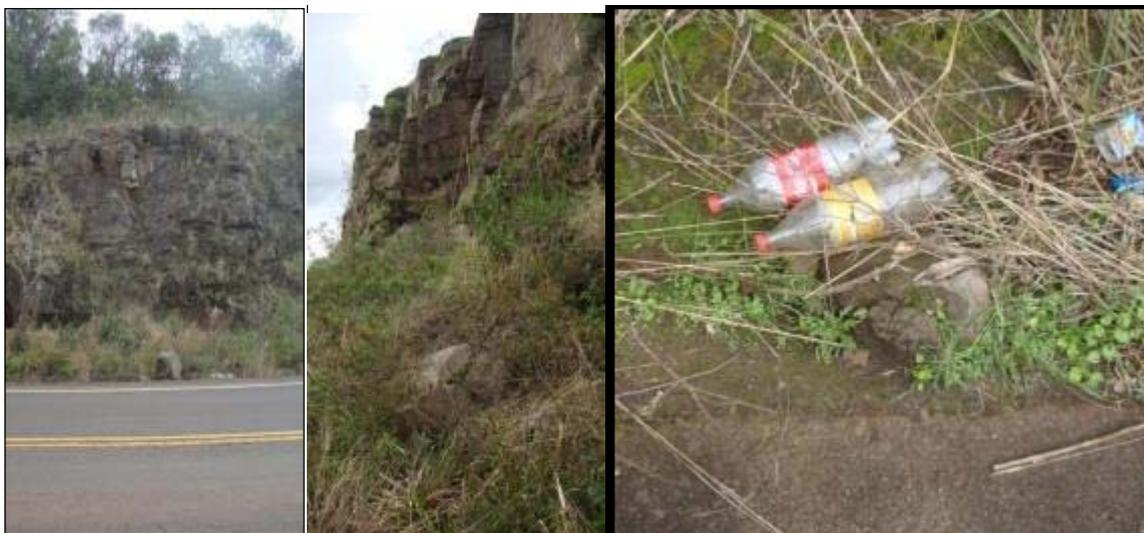
**Foto 18:** A queda de blocos prejudica o sistema de drenagem superficial ao bloquear o fluxo de água e proporcionar o acúmulo de resíduos nas sarjetas.
