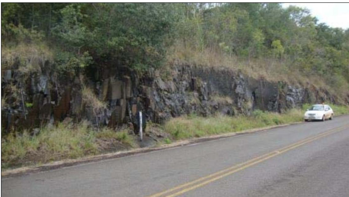
**Foto 32:** Talude rochoso típico de derramens basálticos granulares finos da Formação Serra Geral – Fácies Parapanema – encontrado na rodovia ERS-478
