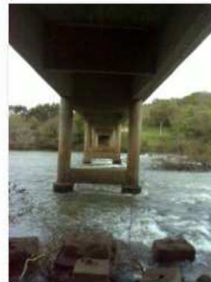
7 - Vista inferior da obra
