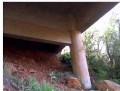
7 - Detalhe do encontro da margem de Sananduva
