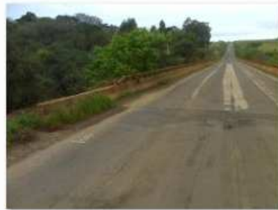
6 - Detalhe do guarda corpo quebrado
