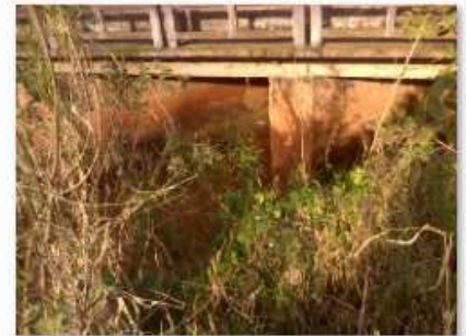
8 - Vista lateral da obra à jusante
