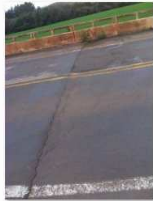
2 - Detalhe da junta no início da obra
