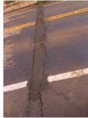
3 - Detalhe da junta início da obra
