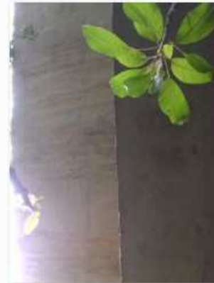
7 - Detalhe da percolação de água na laje
