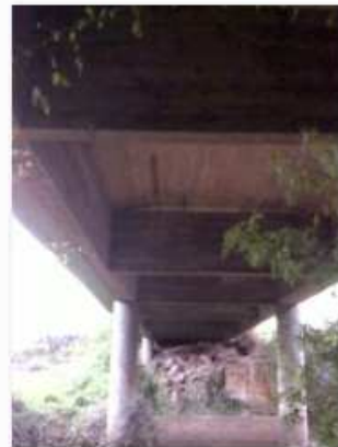
7 - Vista inferior da obra
