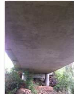
8 - Vista inferior da obra
