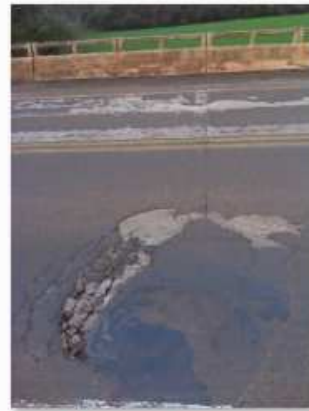
3 - Detalhe do pavimento de concreto quebrado
