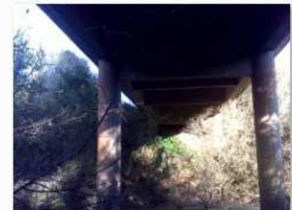
8 - Vista inferior da obra
