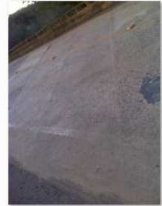
4 - Detalhe do pavimento ao longo da obra
