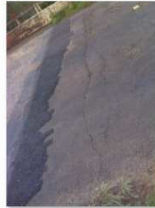
3 - Junta no início da obra
