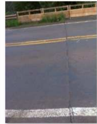
4 - Detalhe da junta no final da obra
