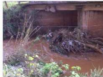
7 - Vista lateral da obra à montante
