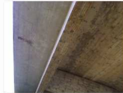
7 - Detalhe de dreno curto com percolação
