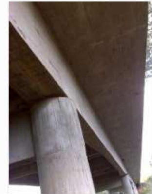
8 - Detalhe de carbonatação no balanço da laje
