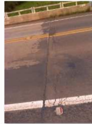
3 - Detalhe da junta no início da obra
