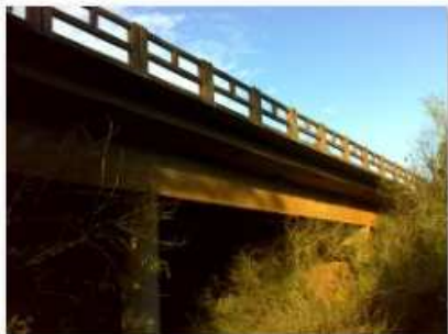
5 - Detalhe dos drenos no balanço da laje
