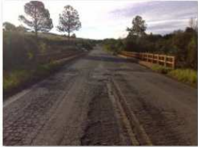
1 - Detalhe da margem de Lagoa Vermelha
