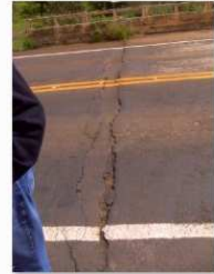
4 - Detalhe da junta no fim da obra
