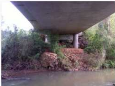
5 - Detalhe do aterro de aproximação
