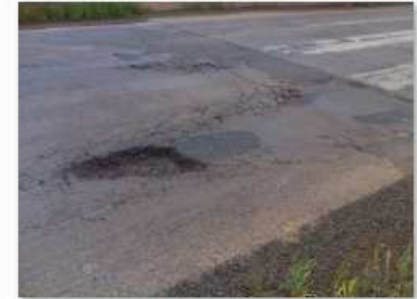
4 - Detalhe da junta no final da obra
