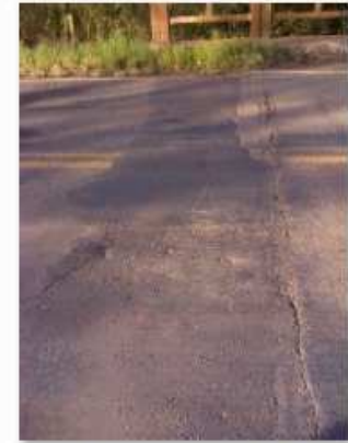
4 - Detalhe da junta no final da obra
