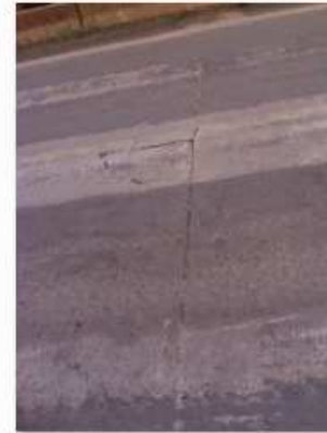
7 - Detalhe do pavimento de concreto
