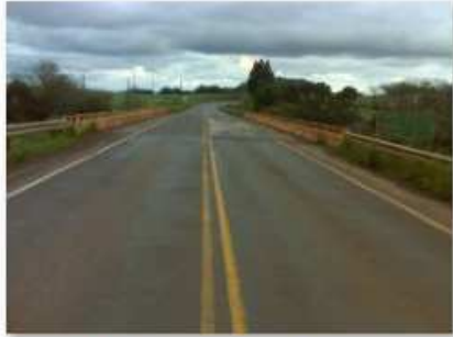
1 - Detalha da margem de Ibiçá
