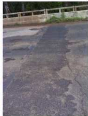
6 - Junta no final da obra
