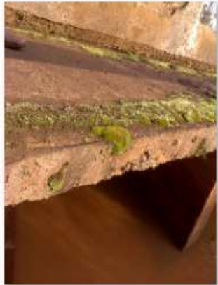
5 - Detalhe da umidade acumulada no passeio
