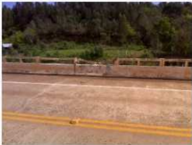
5 - Detalhe de guarda corpo quebrado
