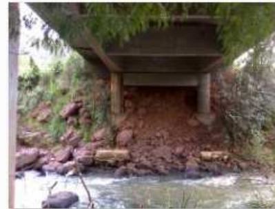
7 - Vista inferior da obra
