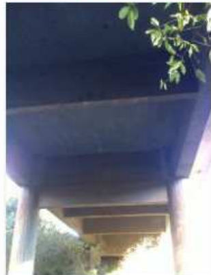
6 - Detalhe da carbonatação na laje
