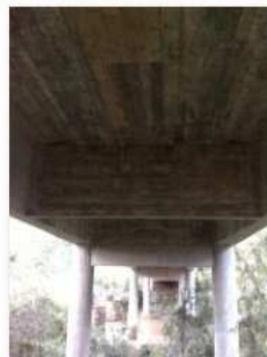
7 - Vista inferior da obra
