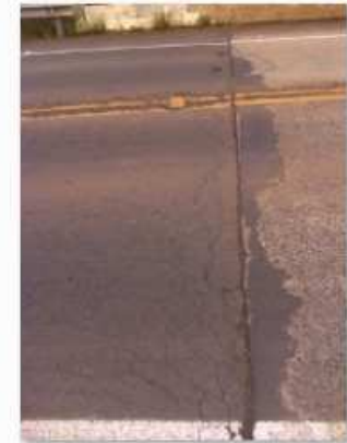
4 - Detalhe da junta no fim da obra
