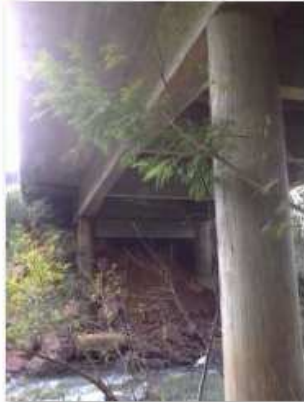
5 - Detalhe do aterro de aproximação
