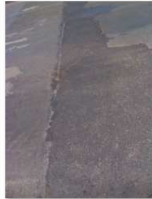
2 - Detalhe da junta de início da obra
