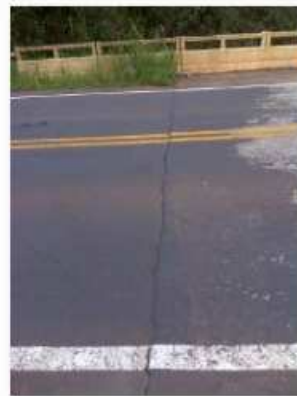
3 - Detalhe da junta no final da obra
