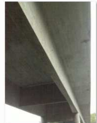
8 - Detalhe do balanço da laje
