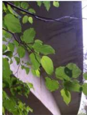
6 - Detalhe do balanço da laje
