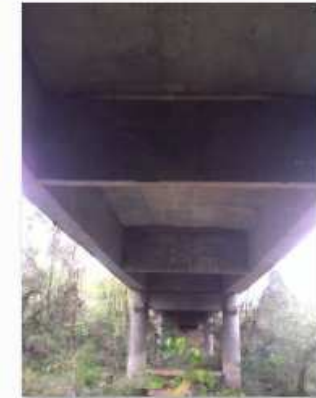
8 - Vista inferior da obra
