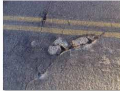
3 - Detalhe do pavimento
