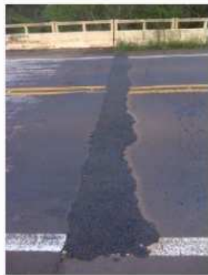
2 - Detalhe da junta no início da obra
