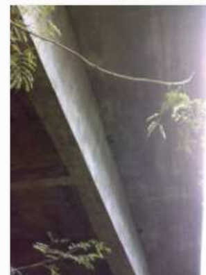
8 - Detalhe da carbonatação no balanço da laje
