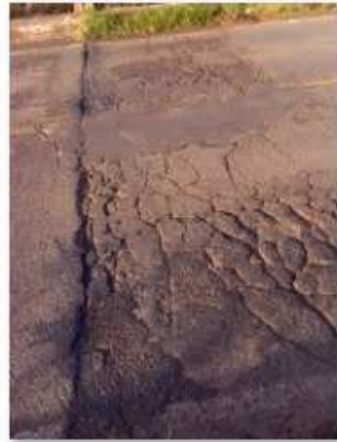
2 - Detalhe da junta no início da obra
