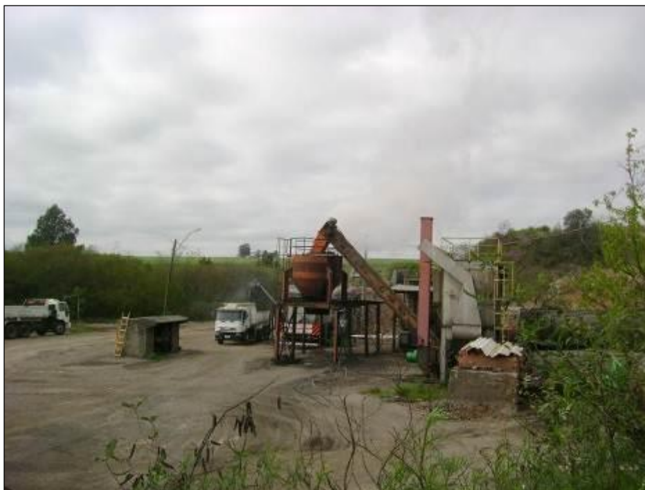
Foto 19 – Visão distal da usina de asfalto da Prefeitura Municipal de Passo Fundo, instalada em área da CODEPAS.
