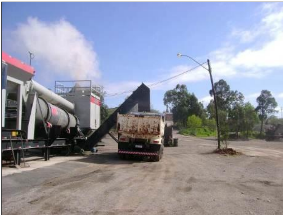
Foto 23 – Carregamento da mistura asfáltica junto à usina.
