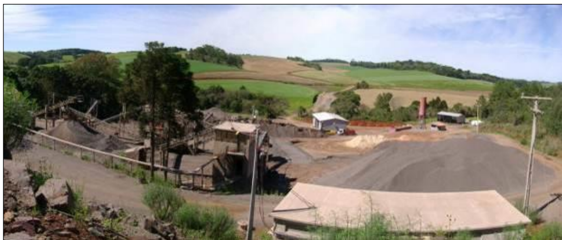
Foto 05 – Tomada fotográfica panorâmica da área da empresa Itax, em Tapejara.
