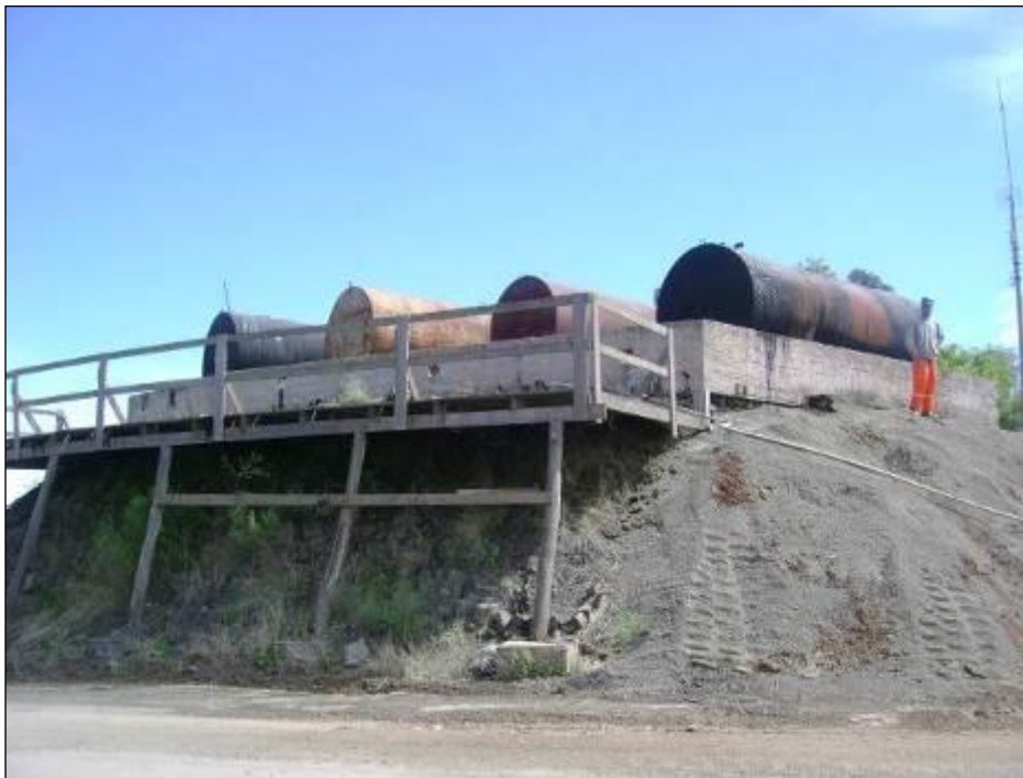
Foto 11 – Tanques de armazenamento das emulsões asfálticas utilizadas no empreendimento da CSL, em Charrua.
