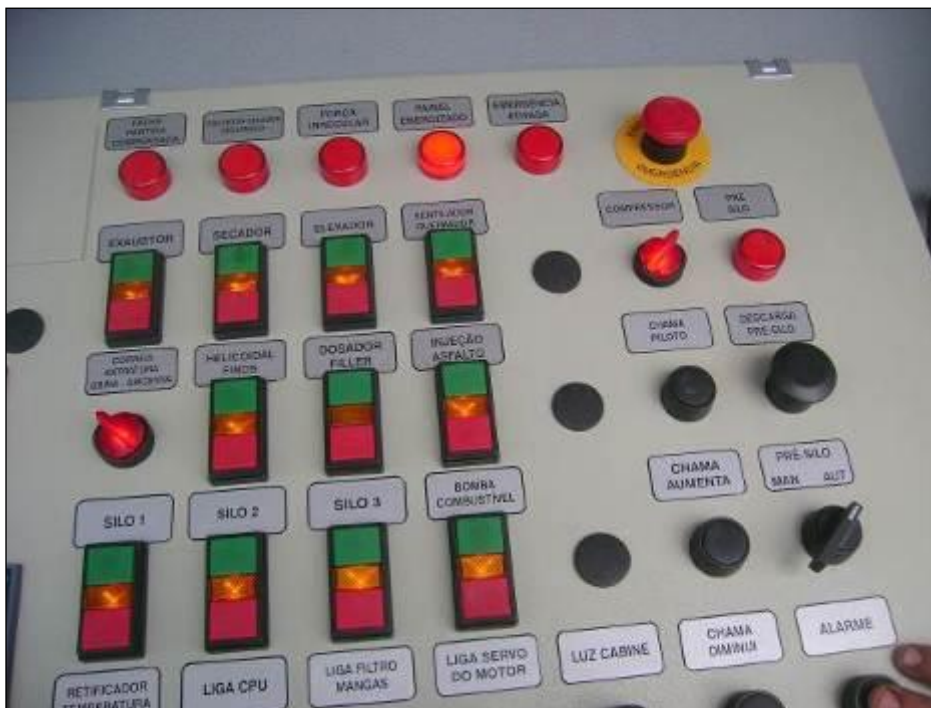
Foto 21 – Painel de controle da usina de asfalto da PM de Passo Fundo.
