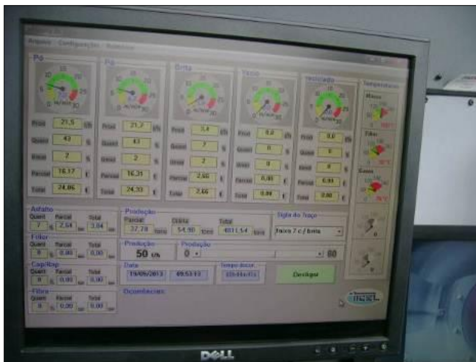
Foto 20 – Detalhe do monitoramento informatizado da nova usina de asfalto de propriedade da Prefeitura Municipal de Passo Fundo.
