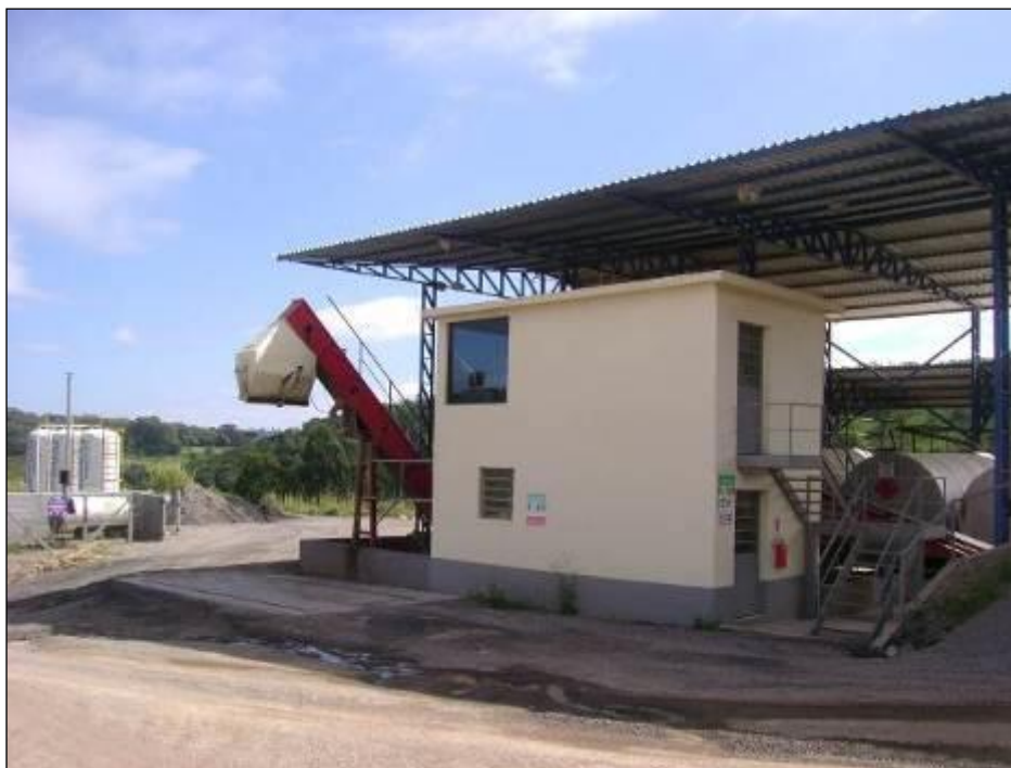
Foto 27 – Usina de asfalto da empresa Construbrás, na localidade de São João da Bela Vista, no município de Passo Fundo.
