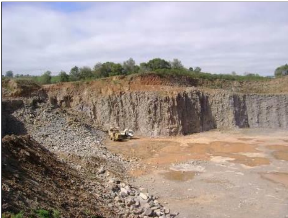
Foto 24 – Frente sul da pedreira licenciada para a Companhia de Desenvolvimento de Passo Fundo (CODEPAS). Existe grande espessura de decapagem e material com características visuais mostrando grande heterogeneidade, com relação a sua qualidade.
