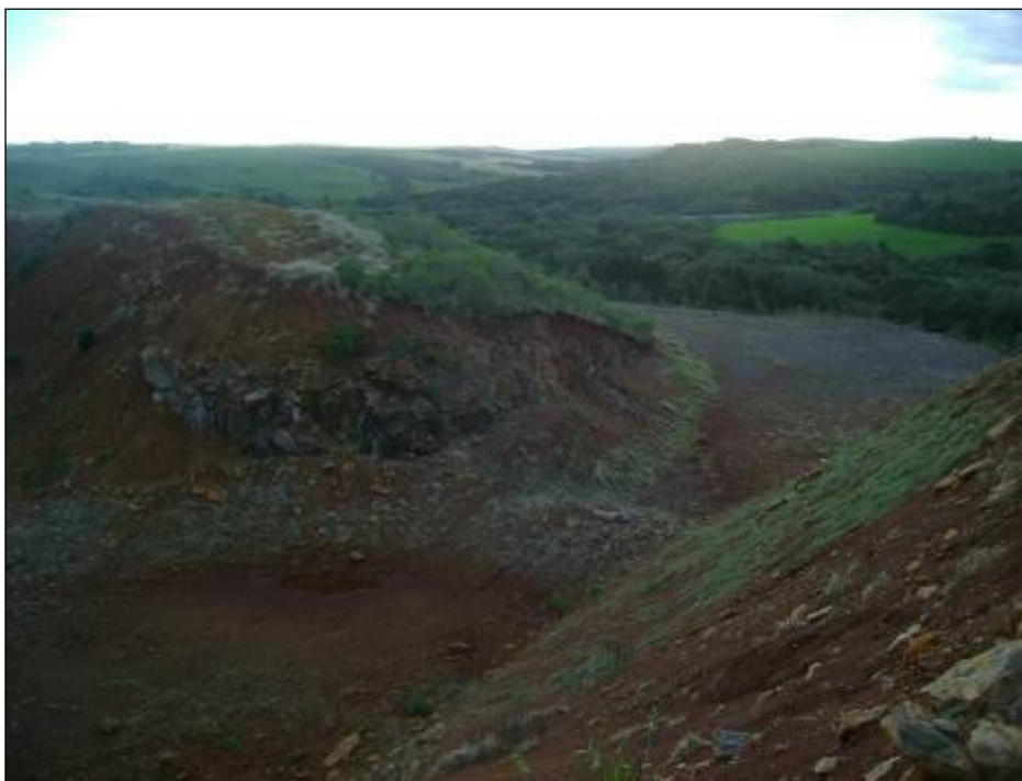
Foto 17 – Visão superior do acesso à área da frente de lavra principal da pedreira da Brasil, no município de Lagoa Vermelha.
