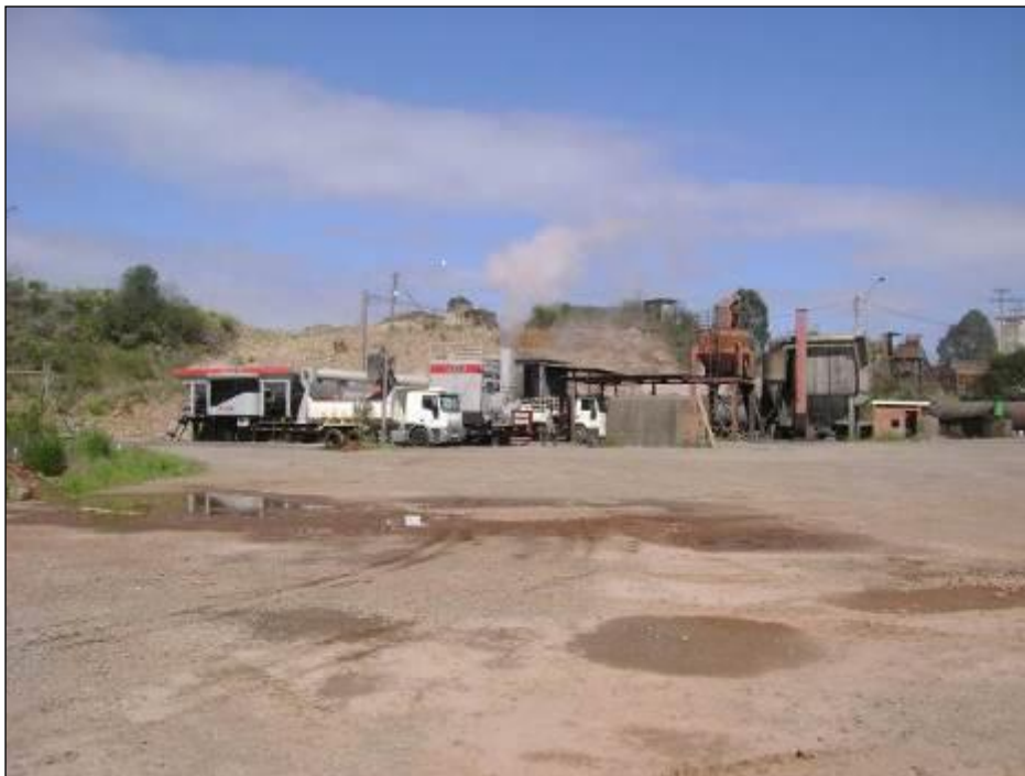
Foto 26 – Tomada fotográfica a partir da unidade enfocada na foto anterior visando usina de asfalto da Prefeitura Municipal de Passo Fundo.
