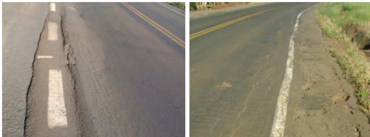
Figura 15 - Reconstrução no km 19+100: 100 metros nas 2 faixas e acostamentos
