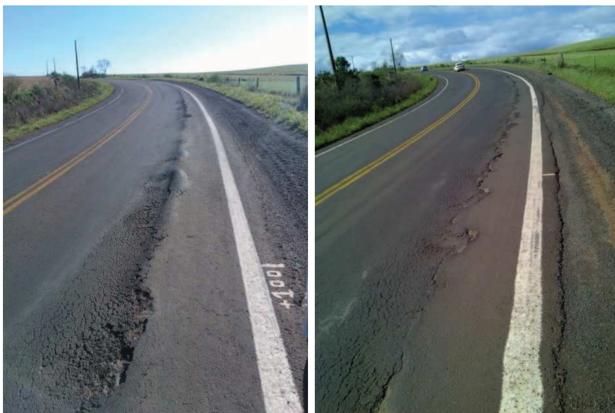
Figura 17 - Reconstrução no km 23+100: 150 metros na faixa do lado direito e acostamento
