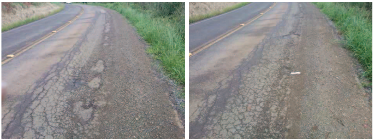
Figura 8 - Reconstrução no km 38+420: 80 metros da faixa do lado direito e acostamento
