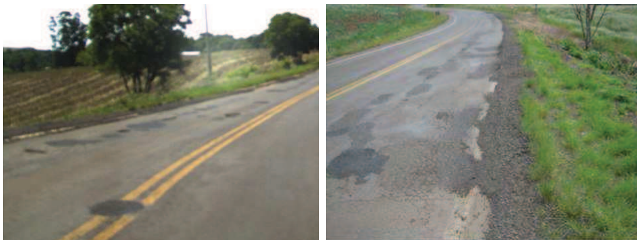
Figura 16 - Reconstrução no km 21+100: 120 metros em na faixa do lado esquerdo e acostamento
