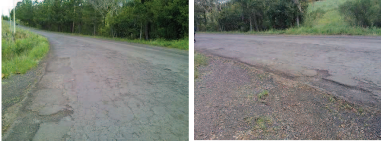
Figura 5 - Local de Reconstrução: km 124 de 450 metros
