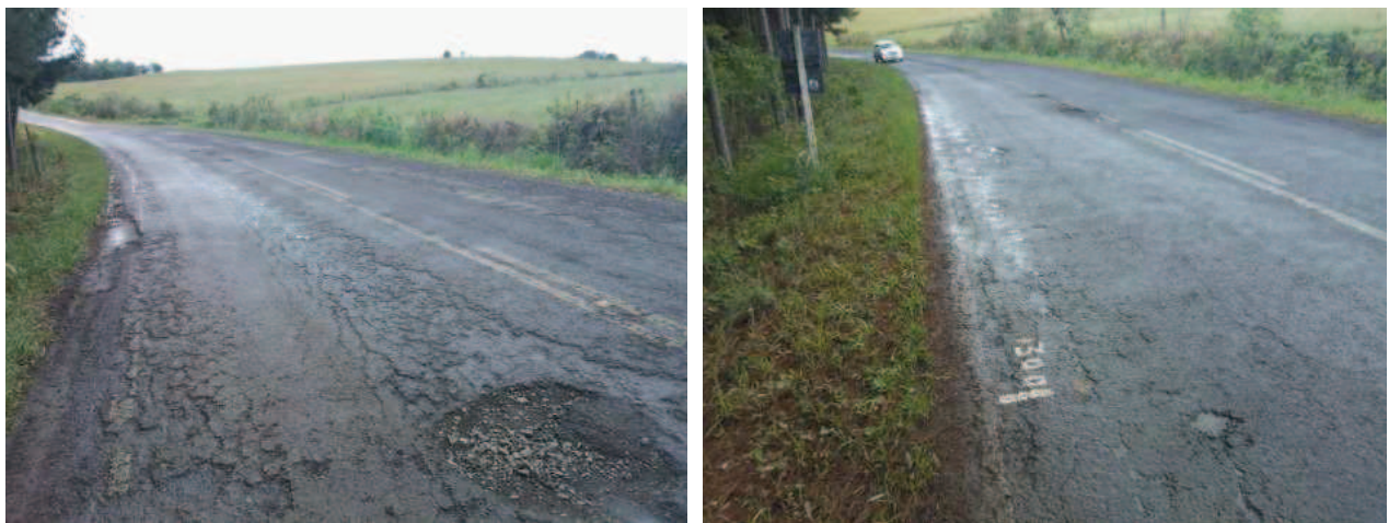
Figura 7 - Reconstrução: no km 34+200, 160 metros nas 2 faixas e acostamento
